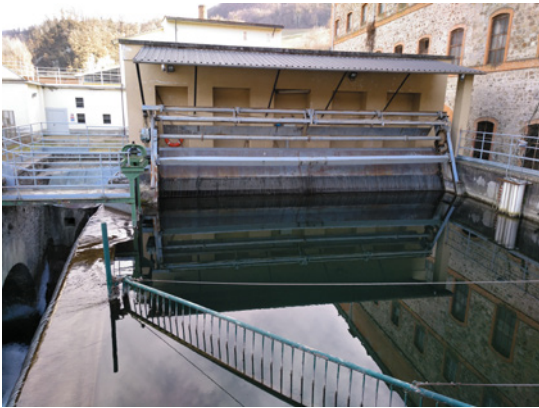
Foto actual de la pequeña presa. Pioppe di Salvaro.
