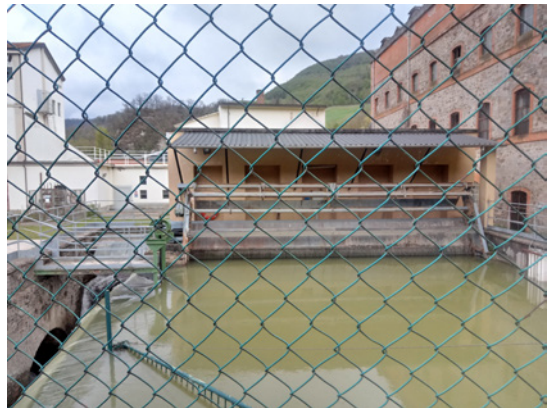
Le bassin de l'usine, où le père Martino Capelli a été mitraillé.
